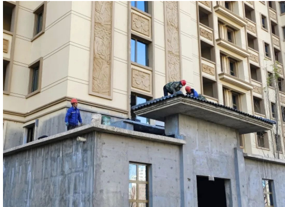
银川天山国府壹号项目施工中
