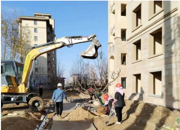
银川天山国府壹号项目施工中
